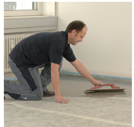
Auftrag des Dünnestrichs UZIN NC 195
