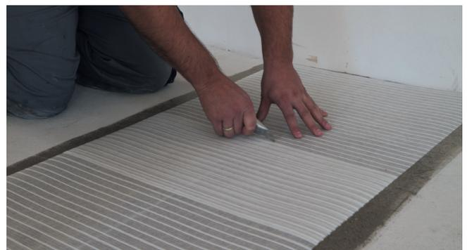
Der Zuschnitt von UZIN RR 203 erfolgt einfach mittels Messer, eine spezielle Schere wird nicht mehr benötigt.
