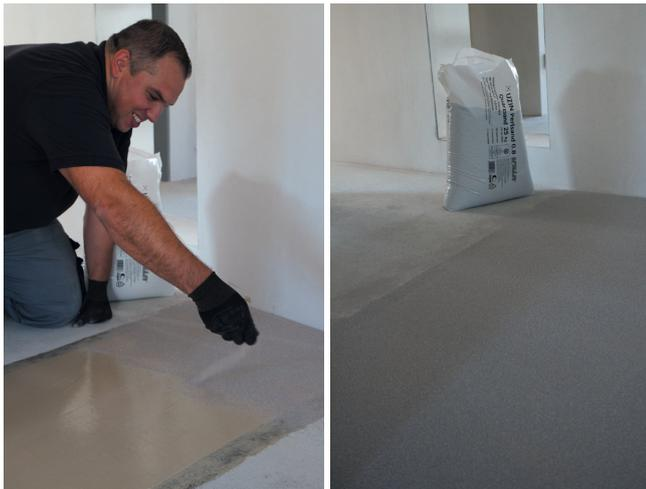
Absanden von UZIN MK 92 S mit UZIN Perlsand 0.8 bei nachfolgenden Spachtelarbeiten.
