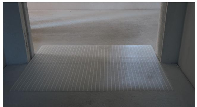
Der Einsatz von UZIN RR 203 Platten reduziert den Aufwand für das Zuschneiden auf Breite und bei z. B. Standardturdurchgängen (80 cm) sogar gänzlich.
