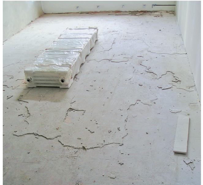
Hier abgebildet: Alter Estrich mit labilen Klebstoff- und dickeren, schlecht haftenden Spachtelschichten. Bei derart maroden Untergründen ist die mechanische Entfernung aller losen Schichten, z.B. mittels Fräse, unumgänglich. Nach gründlichem Absaugen mit geeigneter UZIN Grundierung vorstreichen und UZIN Randdämmstreifen stellen. Für die richtige Spachtelmassewahl gibt es nur eine Lösung: UZIN NC 110 als absolut spannungsarmer Spachtelmasseausgleich für Renovieruntergründe.
