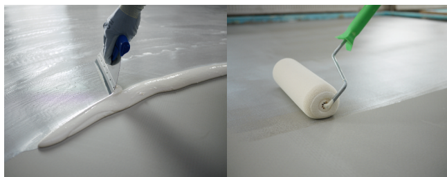
Die UZIN Universalfixierung bietet zwei mögliche Auftragsvarianten.
