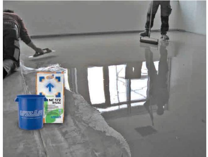
UZIN NC 172 BiTurbo hat die besten Verlaufeigenschaften seiner Klasse, ist ausreichend lange verarbeitbar und trotzdem bereits nach 60 Minuten belegreif. Dieses Bild zeigt die Spachtelung in einem Neubau, wo eine schnelle Belegreife unter schlechten klimatischen Bedingungen erforderlich ist.
