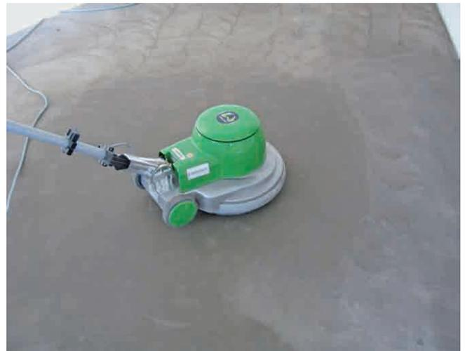
Sollte eine Verlegung später als zwei Stunden nach dem spachteln gewünscht sein, so ist die Schnellspachtelmasse problemlos schleifbar. Trotz ihrer hohen Festigkeit ist ein schnelles und intensives Schleifergebnis zwischen 2,5 und 4 Stunden nach dem spachteln sehr gut möglich.
